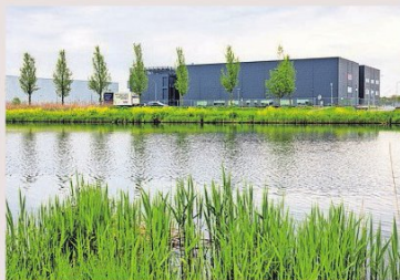
▲ Een nieuw datacenter in Almere. FOTO MAARTEN FEENSTRA
