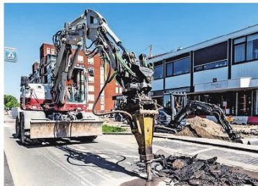
▲ Het wegdek wordt onder handen genomen.
