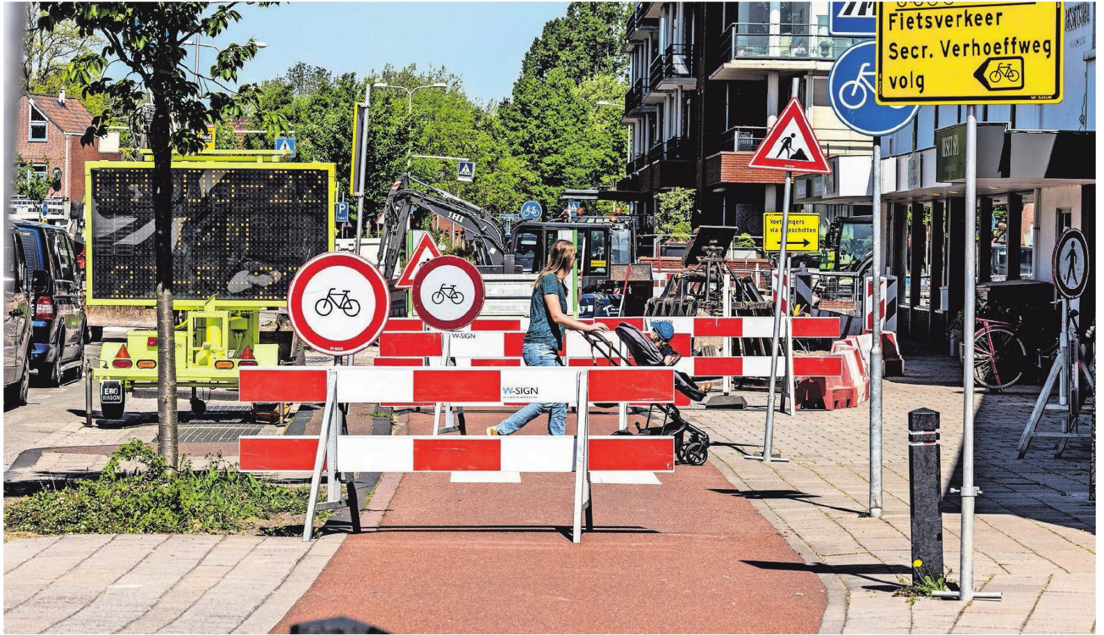
▲ Werkzaamheden aan de Secretaris Verhoeffweg in Naaldwijk. De weg is voorlopig dicht. FOTO'S THIERRY SCHUT
