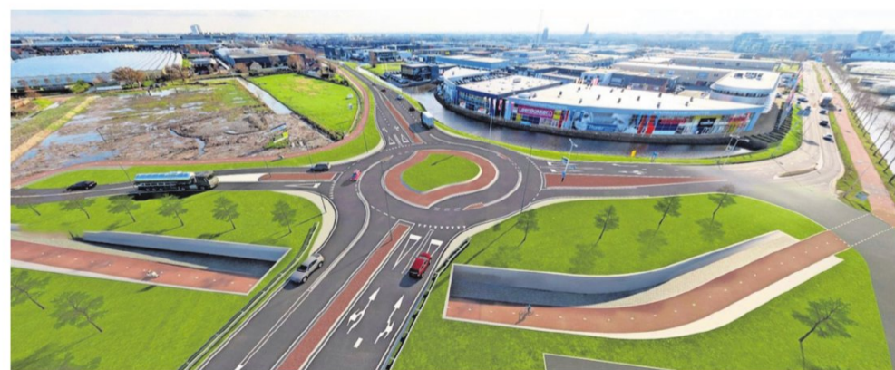
▲ De nieuwe rotonde-Bosweg met op de voorgrond een fietstunnel.
