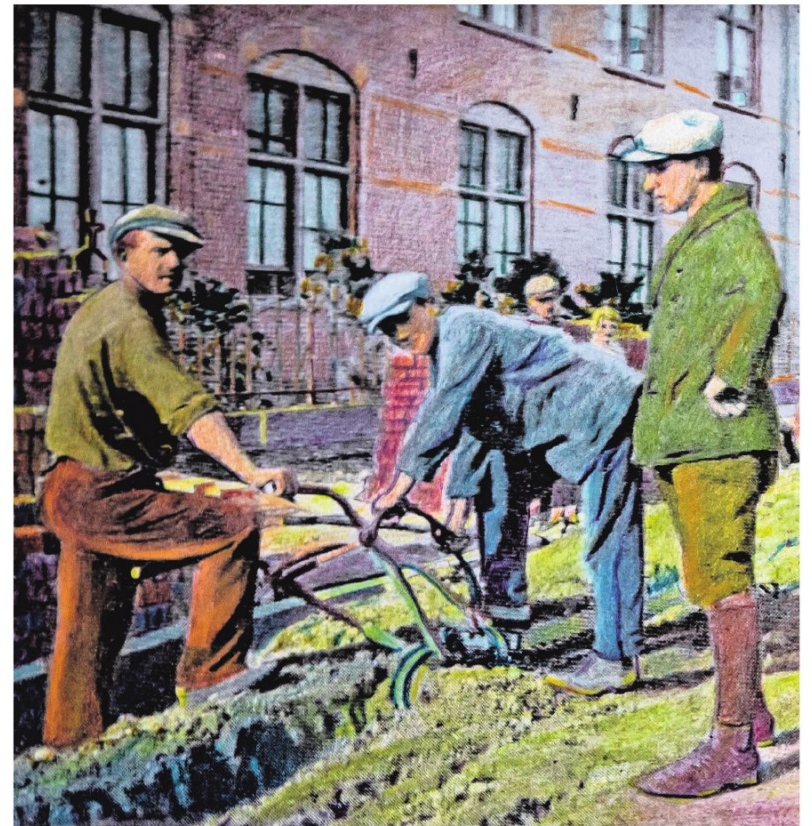
▲ De Voorstraat in Poeldijk, waarbij de oude verharding wordt losgeploegd. ARCHIEFFOTO
